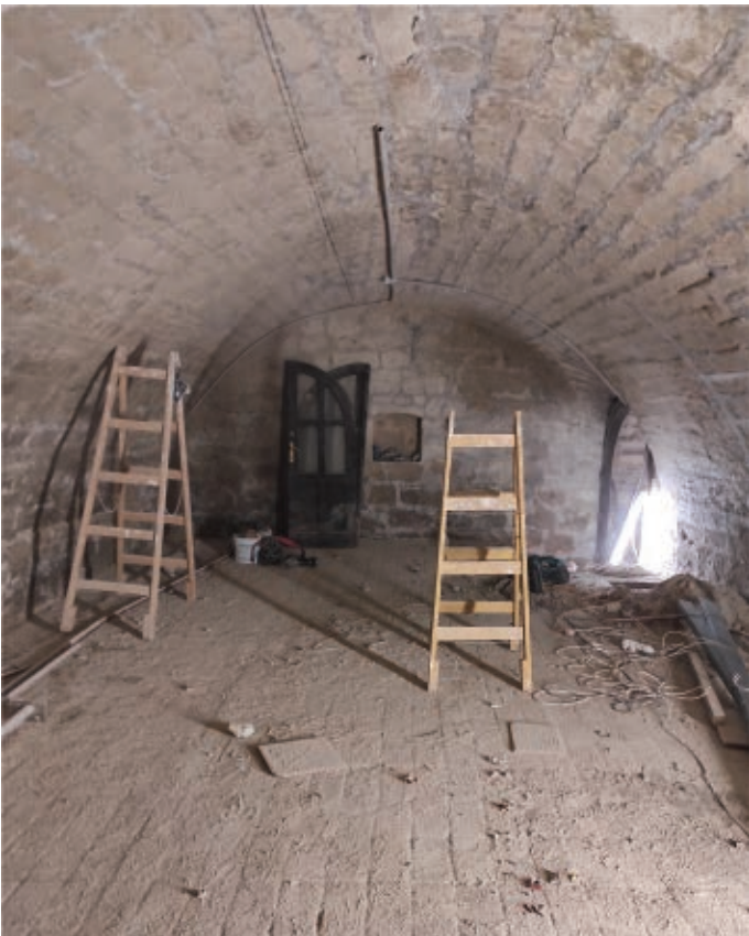
A pince felújítás alatt
